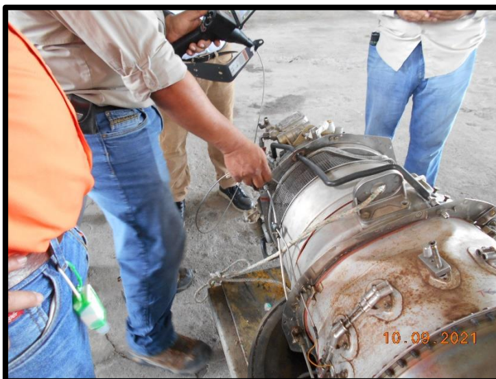
Fotografía No. 13 Vista de revisión de los álabes de las ruedas de la sección de potencia.
