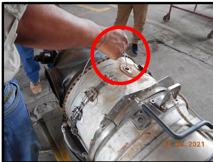
Fotografía No. 14 Vista de la inspección de la sección caliente del motor.
